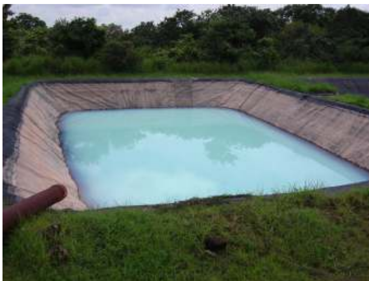
Foto 29. Laguna de sedimentación para descarga de agua geotérmica (PGP-04). Autora: Bi Yun Zhen Wu, 2008.
