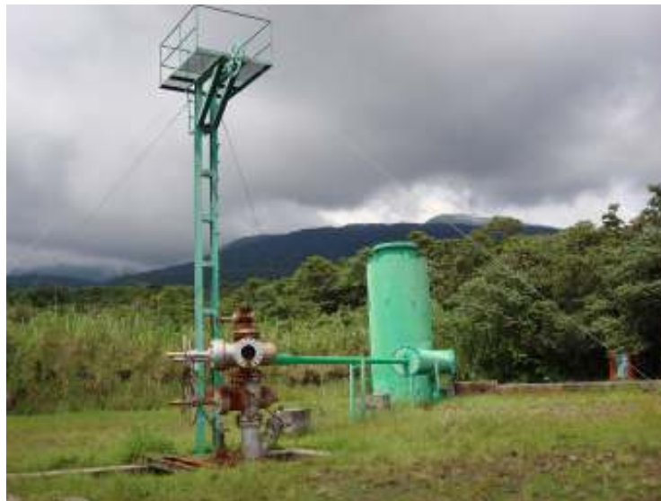
Foto 28. Pozo geotérmico profundo construido (PGP-03).
