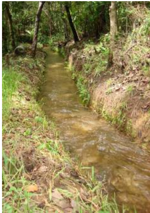
Figura 14. Erosión en los bordes del sitio 4.
