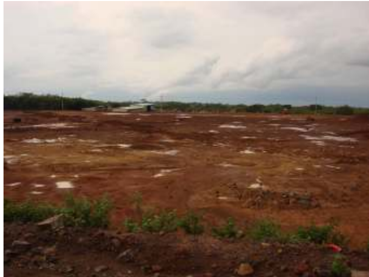
Foto 27. Remoción de tierra para la construcción de la Casa de Máquina del campo geotérmico Las Pailas.
