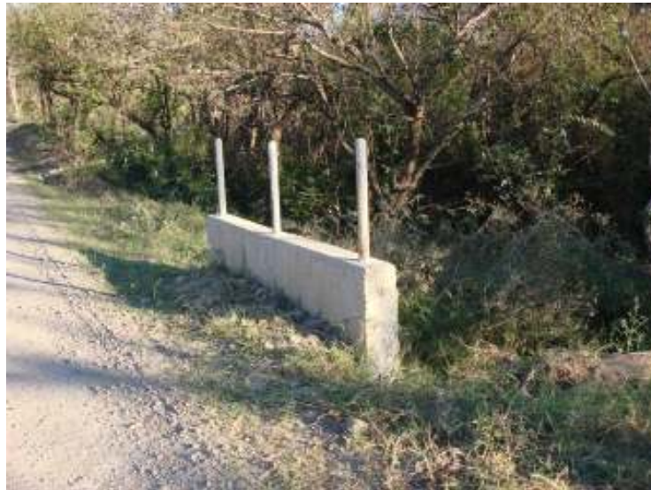
Foto 18. Puente antes de la naciente PGP-05 para el drenaje de aguas pluviales de la carretera.
